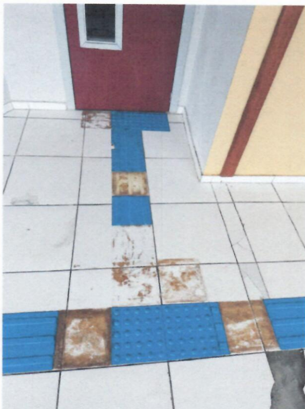
Foto 3 e 4 – Piso tátil descolado; manchas no piso; cerâmica deslocada.
