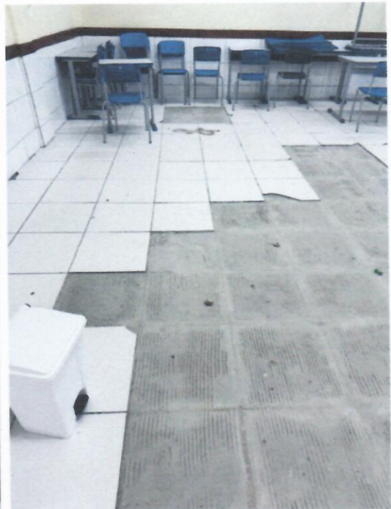
Foto 7 e 8 – Piso descolado, se soltando inteiro e quebrando peças por estarem ocas.
