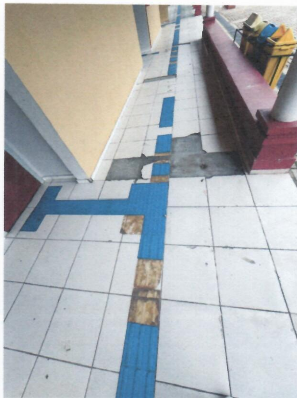
Foto 3 e 4 – Piso tátil descolado; manchas no piso; cerâmica deslocada.
