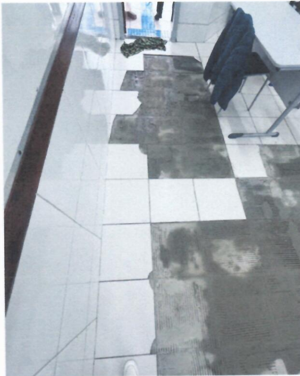
Foto 7 e 8 – Piso descolado, se soltando inteiro e quebrando peças por estarem ocas.
