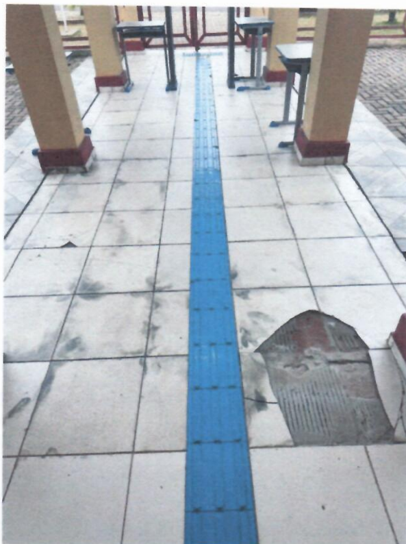
Foto 1 e 2 – Piso manchado; cerâmica trincada; piso tátil descolado.
